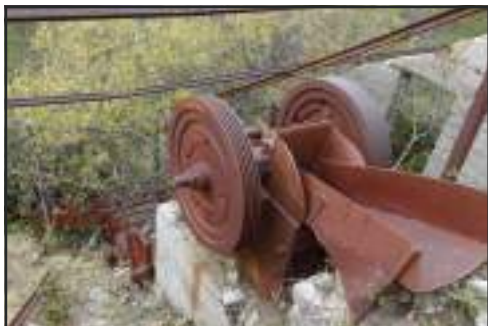
Figura 91. Vista interior del edificio. Se observa como la maquinaria se dispone en un único eje de máxima pendiente de modo que el mineral se introduce por la zona superior de alimentación, desde donde entra en la machacadora de mandíbulas.
